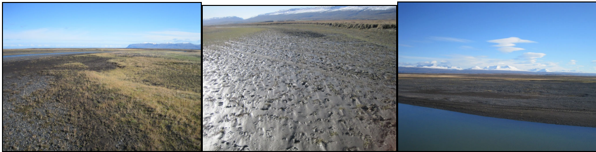
Myndir 32-34: Sumir vatnsálar eru að eyðileggja uppgræðsluna, 20.9.2012
