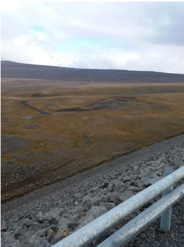
Mynd 15: Nær er svæði E sem orðið er að mestu vel gróið.
