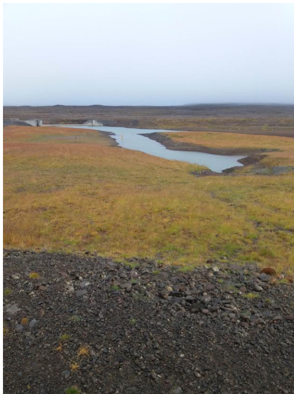
Mynd 24: Við Grjótárstíflu.
