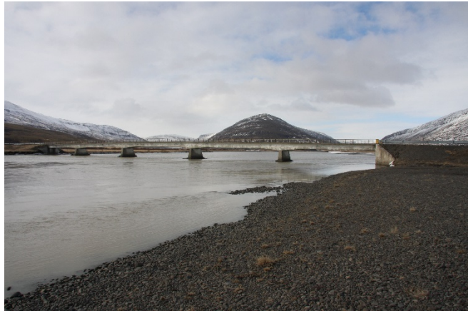
Mynd 12. Gamla brúin yfir Jökulsá í Fljótssdal. Ljósmynd Egill Axelsson.
