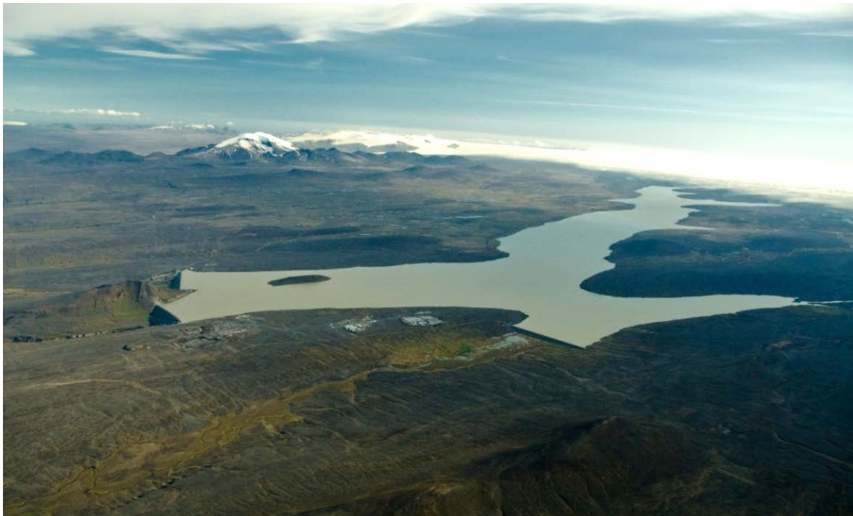
Mynd 1. Háslón með megin stíflu innst í Dimmugljúfrum við Innri Kárahnjúk. Fjær stífla í Desjarárdal og nær í Sauðárdal. Myndin tekin austur yfir Háslón, Vesturöræfi og Snæfell. Ljósmynd. Emil Þór Sigurðsson, 27. ágúst 2007.
