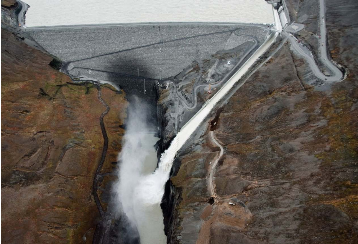
Mynd 6. Yfirfall við Kárahnjúkastíflu. Ljósmynd, Landsvirkjun
