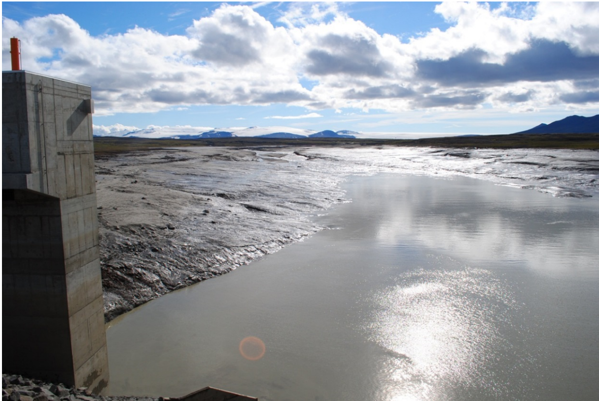
Mynd 77. Að lokinni tæmingu Ufsarlóns. Ljósmynd Georg Pálsson, 27. ágúst 2010.
