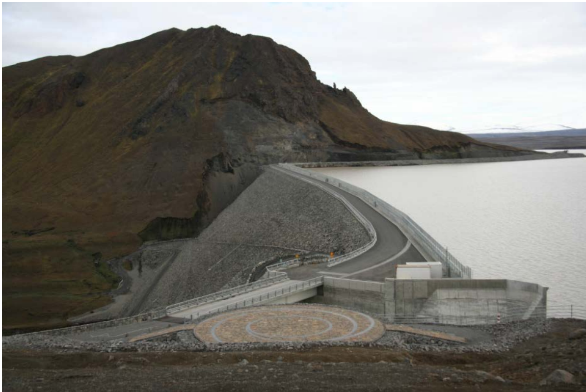
Mynd 59. Kárahnjúkastífla eftir frágang. Í forgrunni listaverkið Hringiða eftir Jónínu Guðnadóttir sem valið var úr hugmyndum í samkeppni um listaverk sem tengdist áningar og útsýnisstað.
