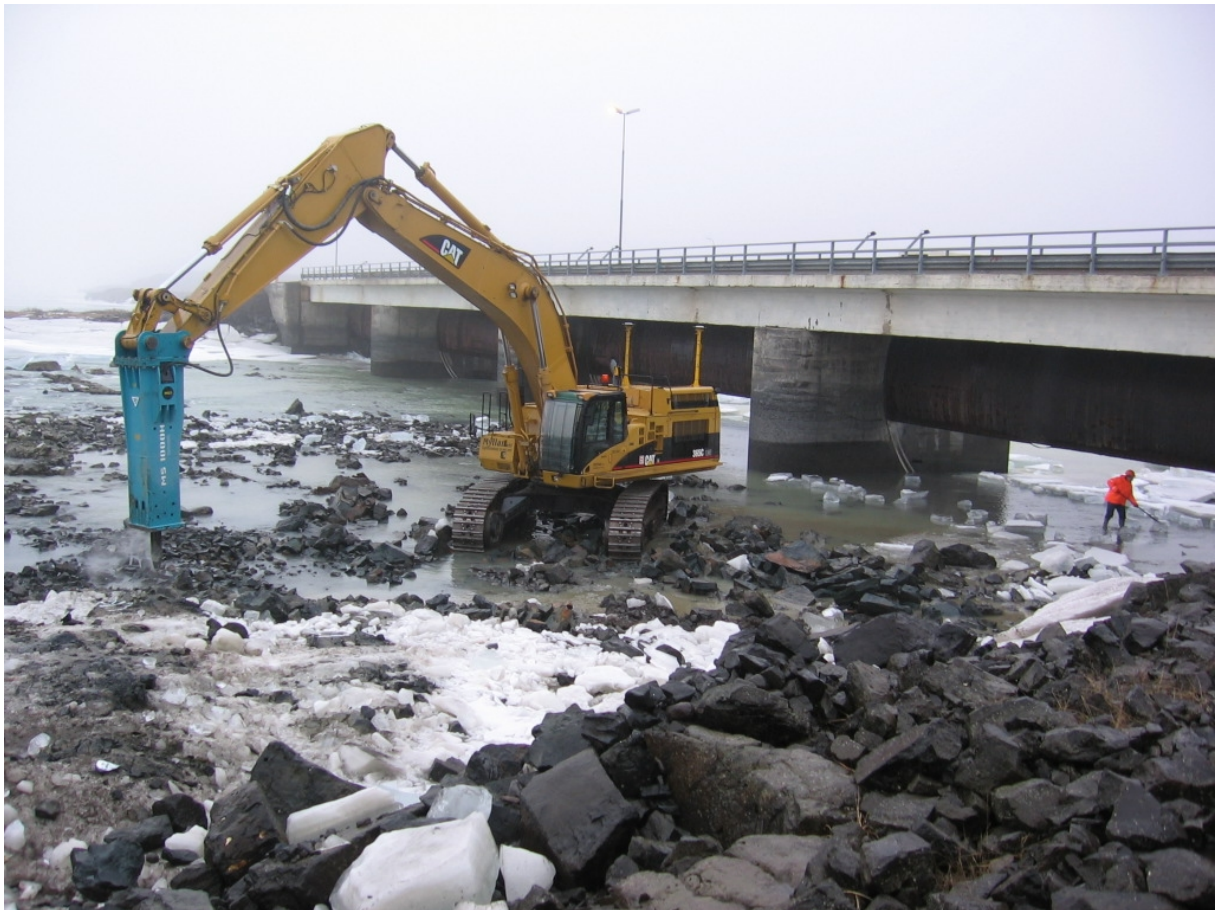
Mynd 32. Unnið við að fjarlægja (lækka) Klapparhaft ofan við lokur við inntak Lagarfossvirkjunar.
