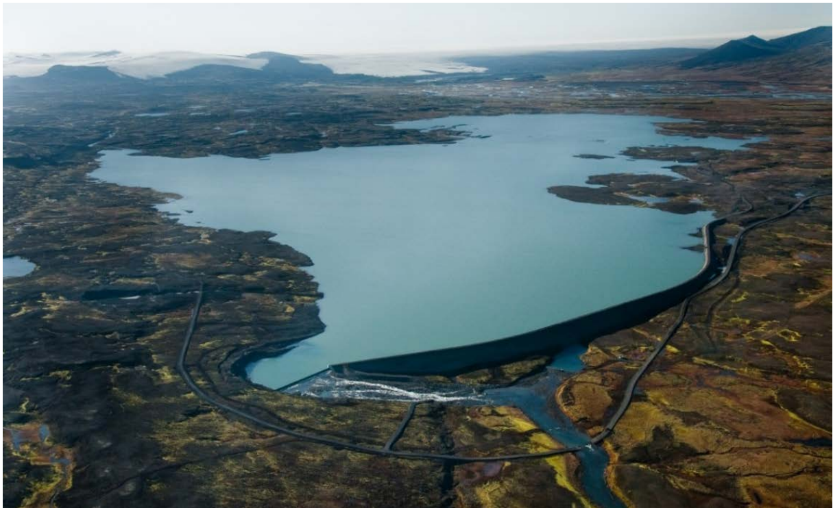
Mynd 4. Breytt fyrirkomulag á yfirfalli Kelduárlóns. Ljósmynd Emil Þór Sigurðsson.
