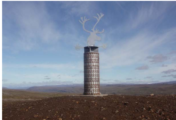
Mynd 30. Gerð og frágangur loftunarhola yfir aðrennslisgöngum virkjunar.
