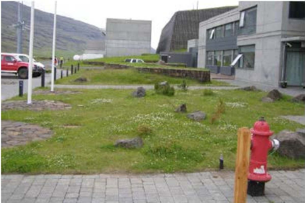
Mynd 60. Aðkoman að stöðvarhúsi Fljótsdalsvirkjunar. Ljós. Pétur Jónsson
