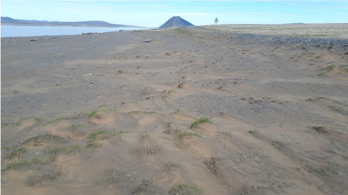
Mynd 6. Á þessu svæði við veginn norðarlega á Lindabungu væri æskilegt að bæta við skurði til að safna fokefnum.
