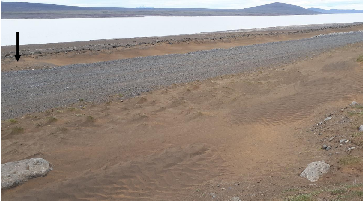
Mynd 6. Skurður lónmeginn við veginn á Kofaöldu sem safnað hefur miklum sandi. Ör vinstra megin á mynd bendir á haft milli skurða þar sem sandur hefur fokið óhindrað yfir veginn og safnast í skafli ofan vegar.
