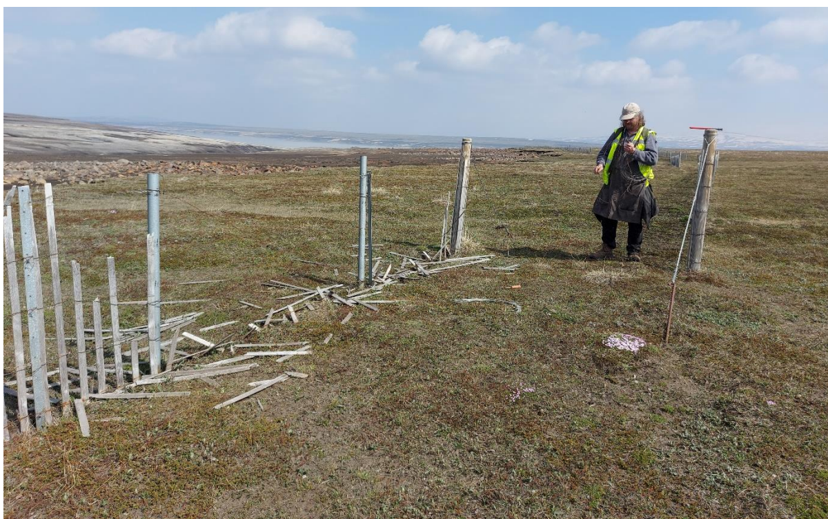
Mynd 18. Fokgirðing í Kringilsárrana sem að öllum líkindum hefur brotnað vegna ágangs hreindýra.
