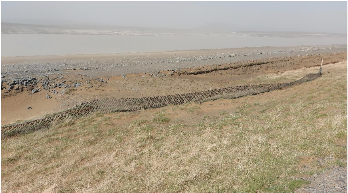
Mynd 2. Nýtt áfok áberandi við skurði sem grafnir voru vestan vegar á austurströnd Háslóns, sem fyrirbyggjandi aðgerðir til að safna áfoksefnum og verja gróið land austan vegar. Fokgirðingar fanga hluta efnisins.
